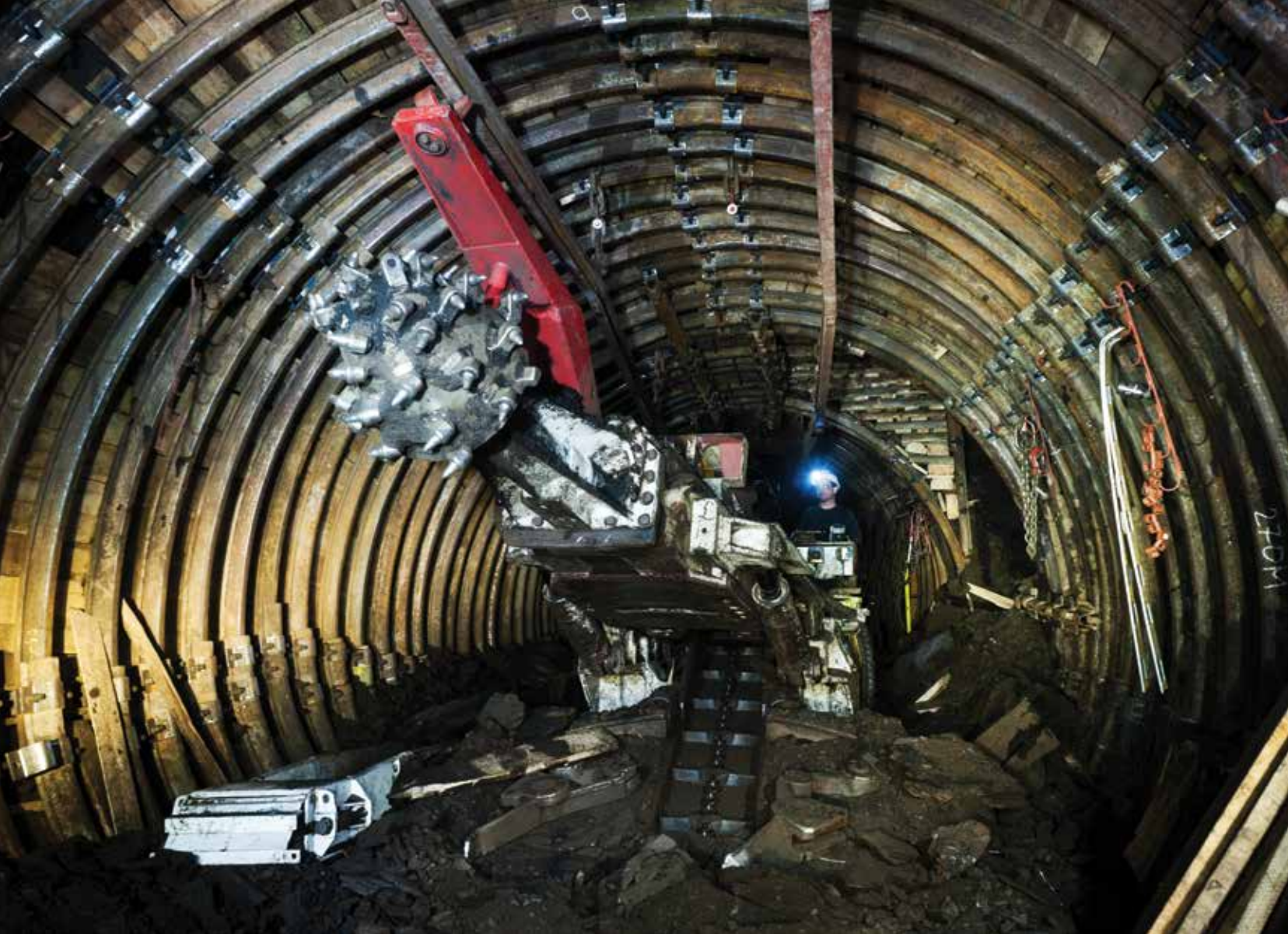
Izdelava nove jamske proge v Premogovniku Velenje Foto: Miran Beškovnik
